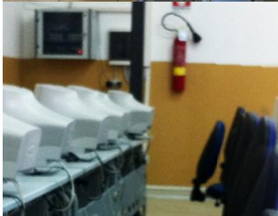
Particolare dell'armadio Rack con all'interno il Router, del Quadro Elettrico e dei tavoli con passacavi posizionati sotto il piano di lavoro.
